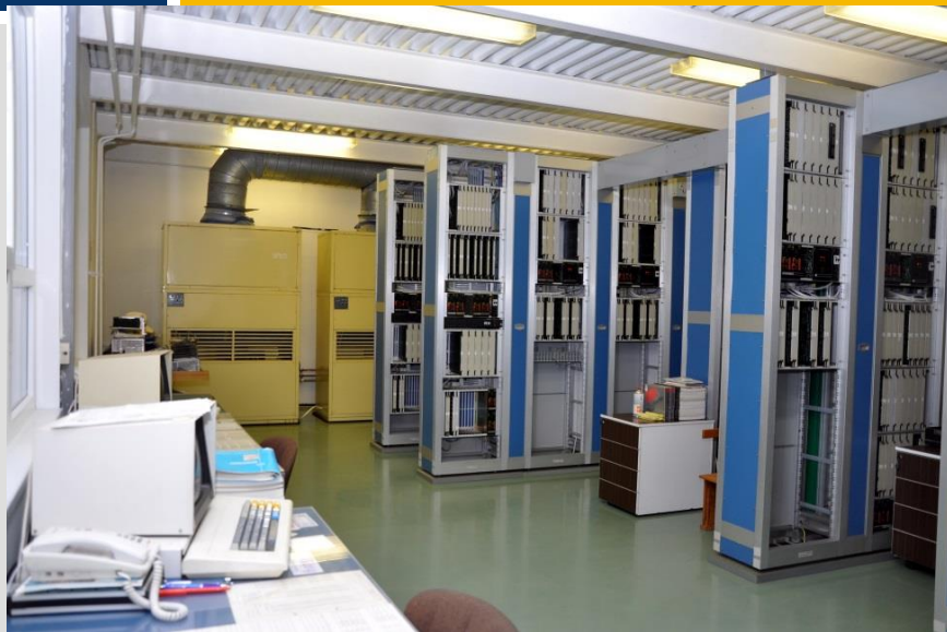
A dombóvári EP512 központ, háttérben az 1991 óta üzemelő klímaberendezéssel
